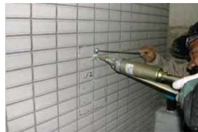
エポキシ樹脂の注入
